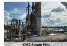
OMS Secant Piles
