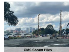
OMS Secant Piles
